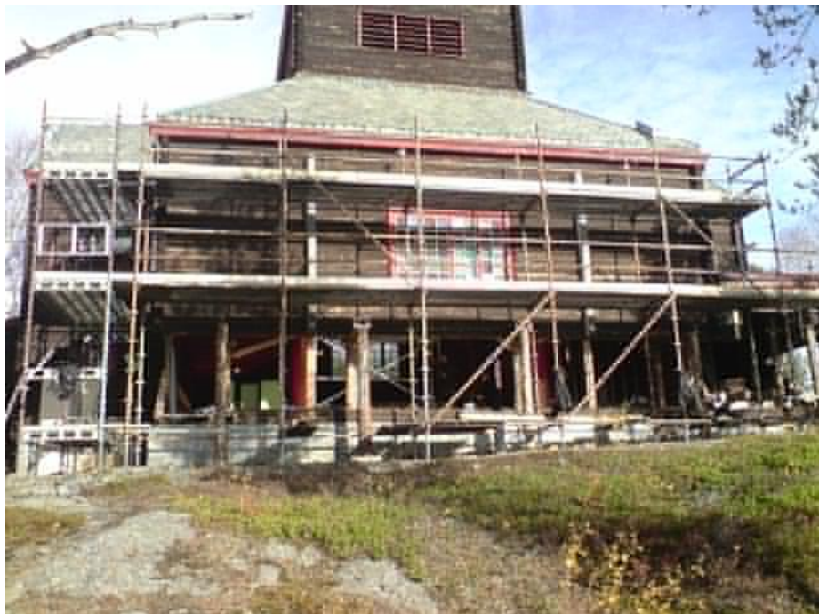
Rehabilitering av Svanvik kapell. Foto: Pål Ballo
